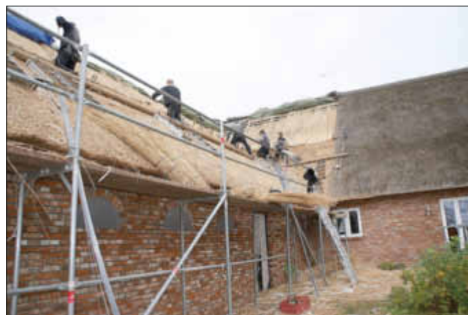
Eine 1.000 qm große Reetdachfläche wird neu eingedeckt.
