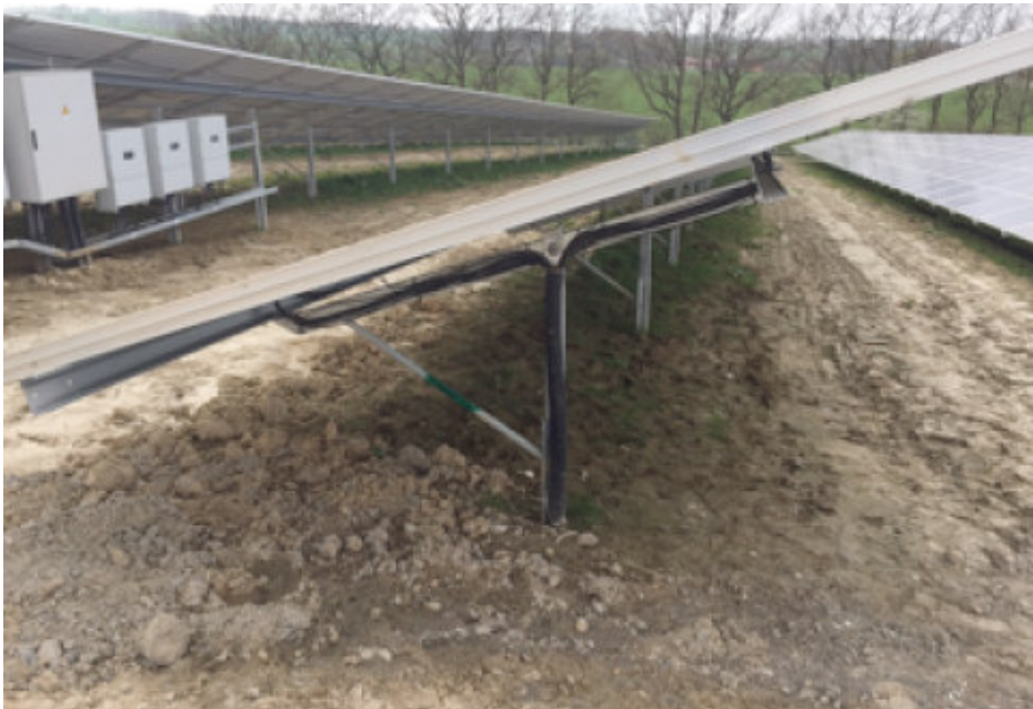
Abb.1: Darstellung der geplanten Tischkonstruktion (während der Bauphase)
