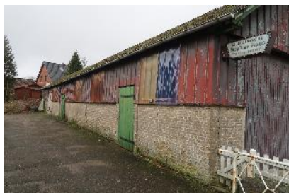
Abbildung 26: Leerstand Nien Damm, nördlich Nr. 17
