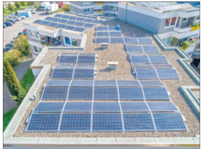
Ein Aufgabenbereich ist die Prüfung des energetischen Sanierungsbedarfs kommunaler Bestandsgebäude und Solarkataster Foto: © Solarimo by pixabay
