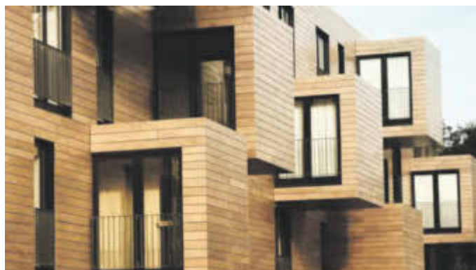
Das Naturmaterial Holz bietet alle Voraussetzungen für Gebäude mit besonderem Charakter.
