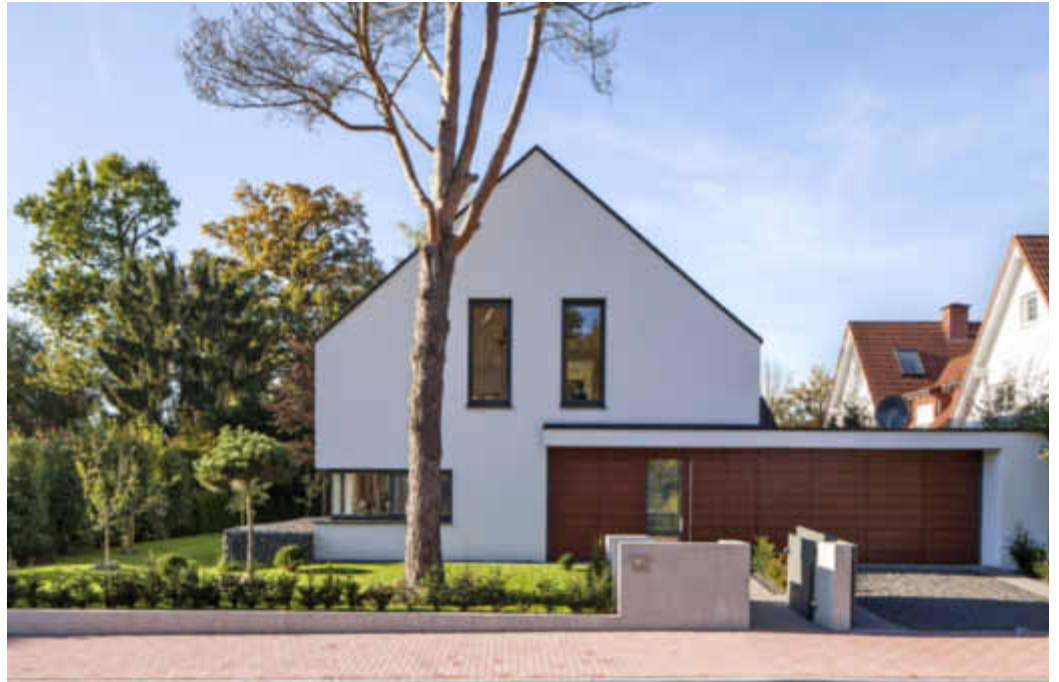
Attraktivität von Dauer: Ein Architektenhaus in massiver Ziegelbauweise. Foto: djd/Lebensraum Ziegel/Poroton/J. Vogt
