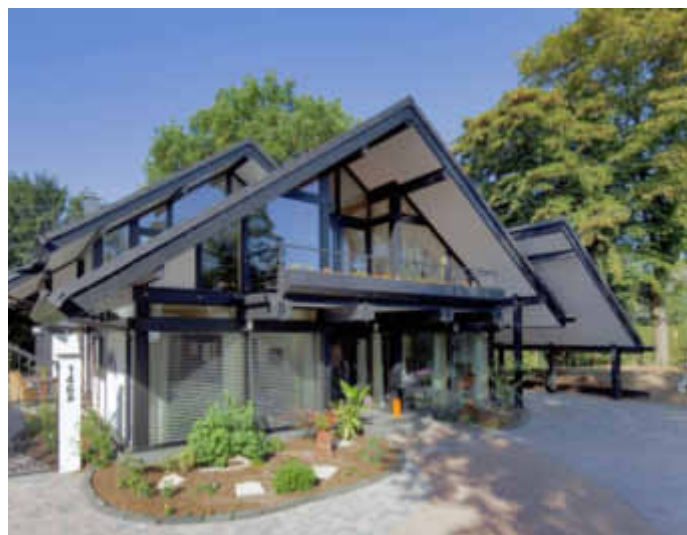
Zeitsparende Bauweise mit Holz: Alle Elemente des neuen Eigenheims werden nach bewährten handwerklichen Techniken im Werk vorgefertigt und dann vor Ort nur noch montiert. Foto: djd/flock-haus
