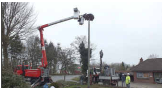
Aufrichtung des Mastes mit der neuen Nisthilfe, die Verfüllung bzw. storchengerechte Herrichtung erfolgt vom Hubsteiger aus, ca. 300 Liter grobes Schreddergut sind eingebracht worden
