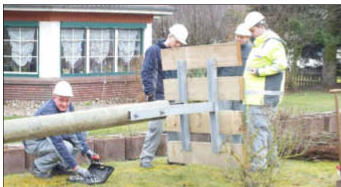
Montage der Halteplattform an der Mastspitze des 11 m Mastes
