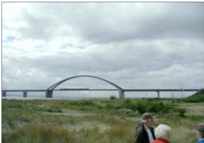
Der Kleiderhaken - Fehmarnsundbrücke
