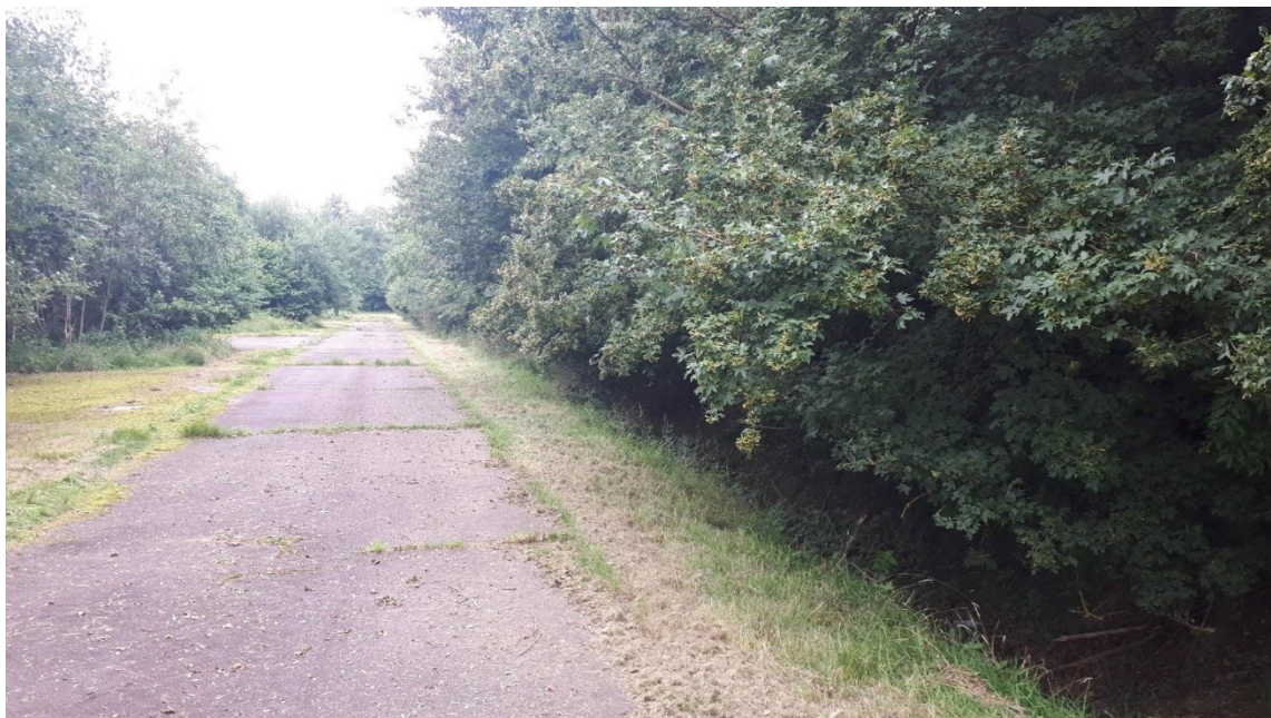
Abb. 9: Blick entlang des südwestlichen Weges von Nord nach Süd blicken, am rechten Straßenrand wird der Zaun gebaut, am linken Straßenrand wird die Leitung verlegt. (Foto: C. Grave)
