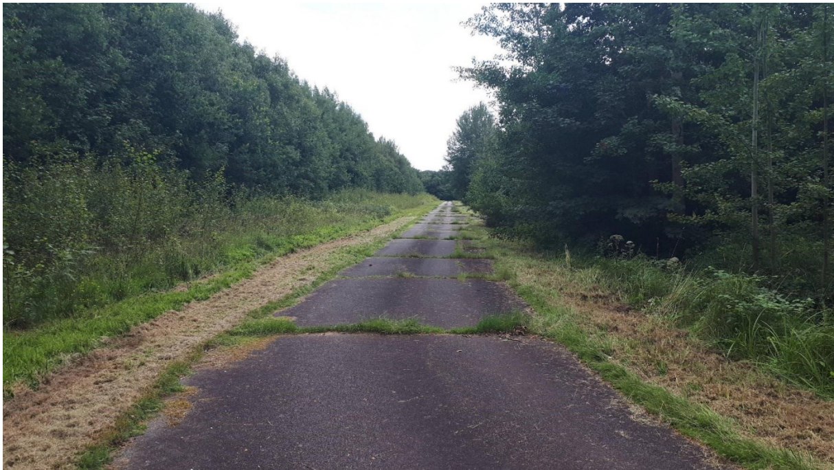
Abb. 10: Blick entlang des nordöstlichen Weges von Nord nach Süd blickend, am linken Straßenrand wird der Zaun gebaut. (Foto: C. Grave)
