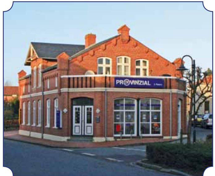
Provinzial nach Umbau 1994
